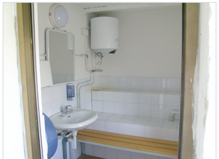
Nuovi servizi nella casetta Jona
