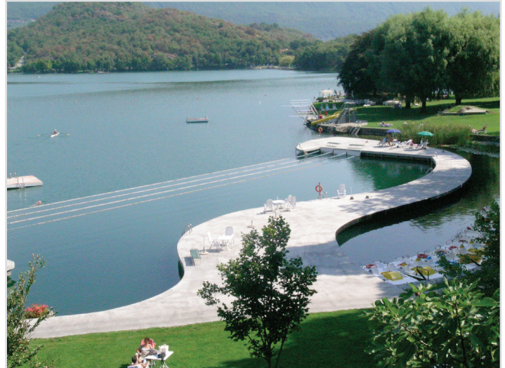
Rifatto il manto superficiale del pontone
