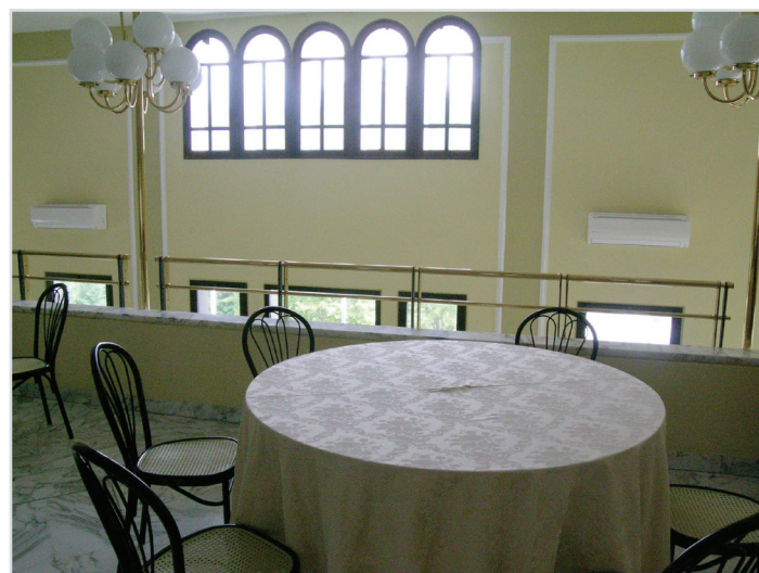
Impianto condizionamento per la sala da pranzo
